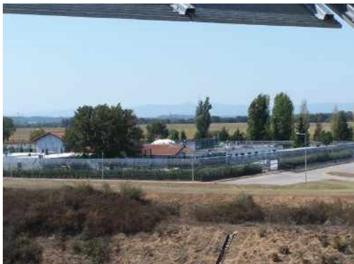
Centre de rétention pour expulsions de St Exupéry
